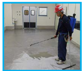
洗浄及び散水
