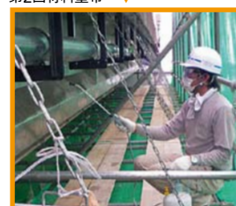
三次散水(兼残材清掃)
