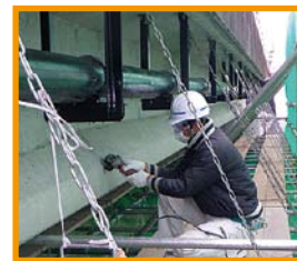
防水下地処理
