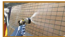
洗浄及び散水
