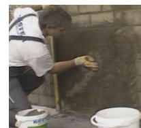
塗布した KD1 に擦り込み硬化させます 図 4
