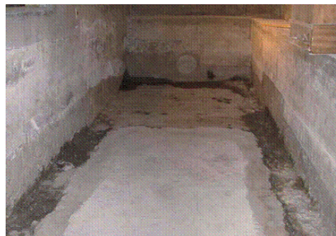
NB1 スラリー塗布前 (水を除いてもすぐに水が溜まる状態) 塗布後 (入隅だけが変色し漏水の出口判明)
