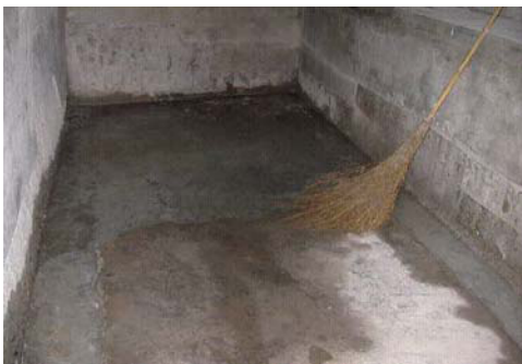
NB1 スラリー塗布前 (水を除いてもすぐに水が溜まる状態) 塗布後 (入隅だけが変色し漏水の出口判明)
