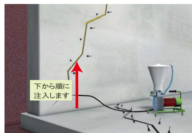
漏水がある場合の手順 2： 10分以内に同じプラグから KÖSTER KP2を注入
