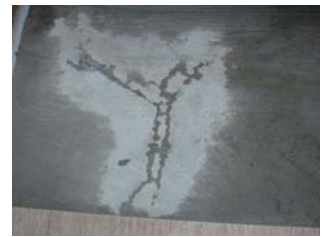
クラック部 V カット後補修モルタルを充填し防水したものの再度躯体との界面から漏水した例 躯体の動きが原因なので注入が必要
