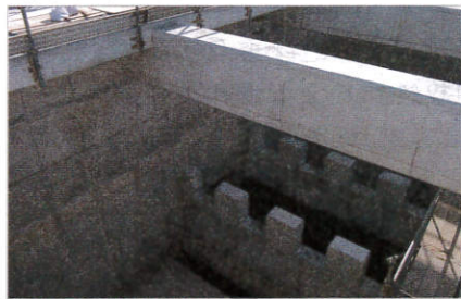
●浄水場の施工風景
