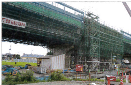
●北陸新幹線の施工風景
