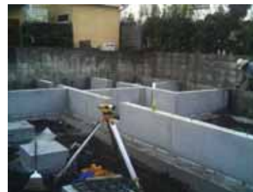
RC養生用塗布後
