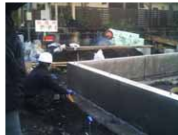
RC養生用塗布後
