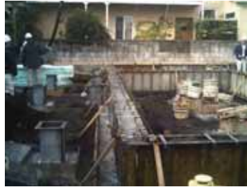
コンクリート打設中
