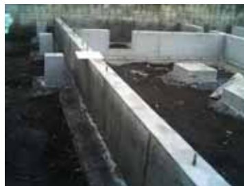
RC養生用塗布後
