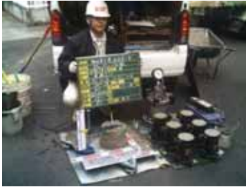
コンクリート打設中
