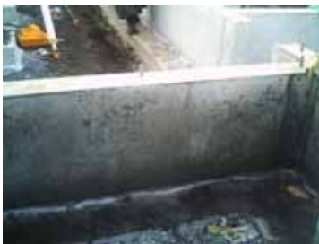
RC養生用塗布後
