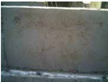
RC養生用塗布後
