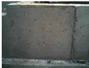
RC養生用塗布後
