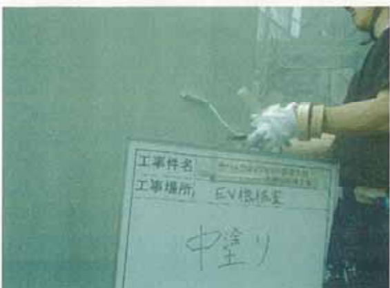
EV機械室 中塗り状況
