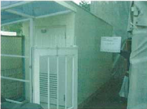
EV機械室 施工前
