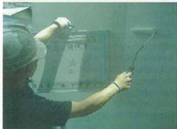
EV機械室 下塗り状況
