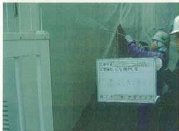
EV機械室 高圧洗浄
