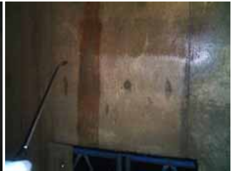
2回目散水養生
