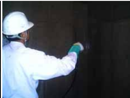
2回目散水養生
