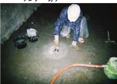
止水部 仕上げ
