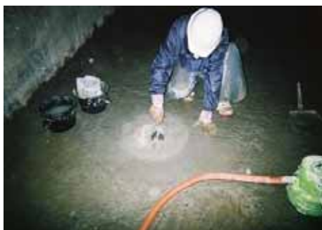
止水部 仕上げ
