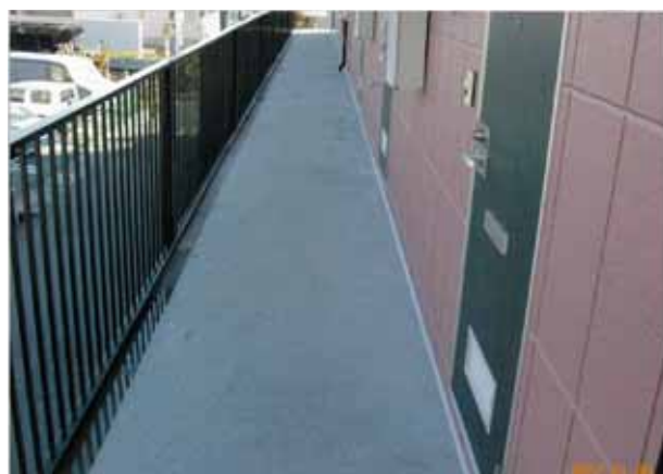
2階通路施工後
