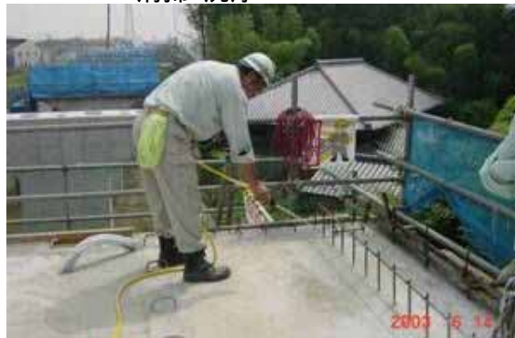
養生コンプロ散布
