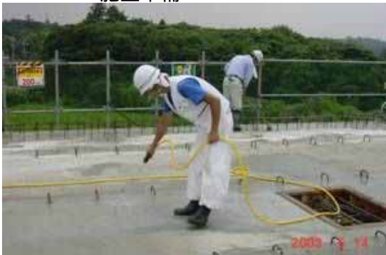
養生コンプロ散布
