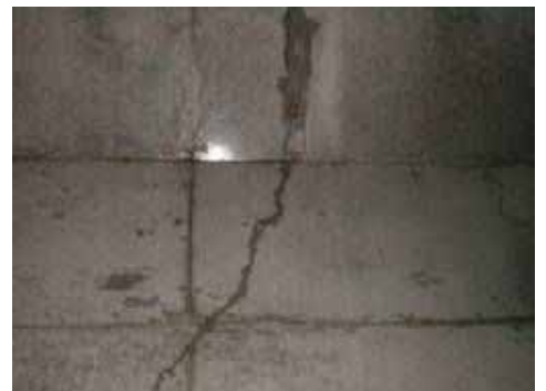
1次散水後内部
