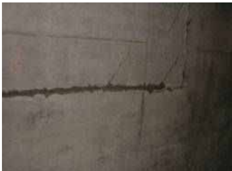
1次散水後内部
