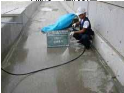
2次散水・湿潤養生
