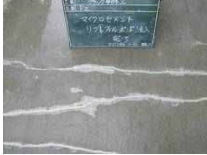
注入完了・養生
