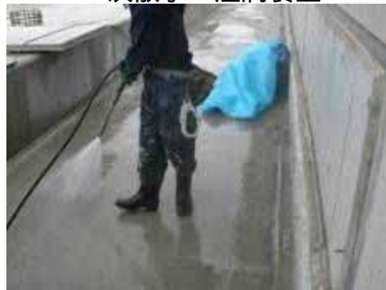
1次散水・湿潤養生
