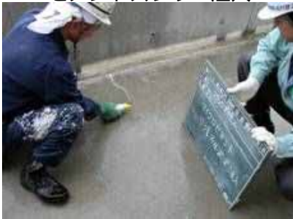
セメントスラリー注入
