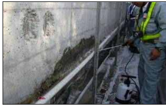
【コンプロ施工】
