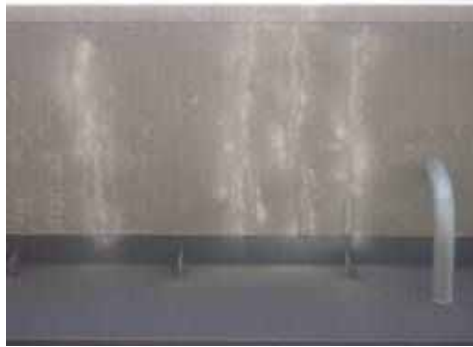
着工前外観(珪素注入施工剤3日前)
