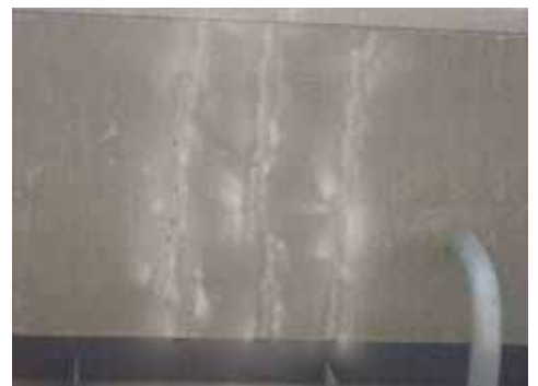
施工終了直後(コンプロ躯体貫通) 2
