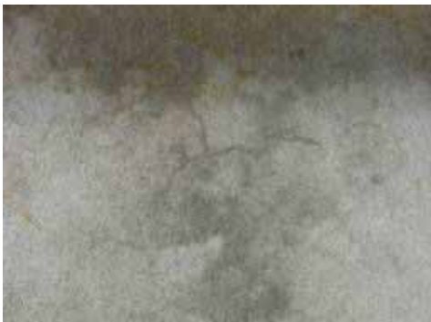
コンプロ散布後の躯体面1
