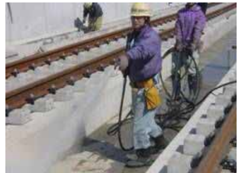
散水・湿潤養生
