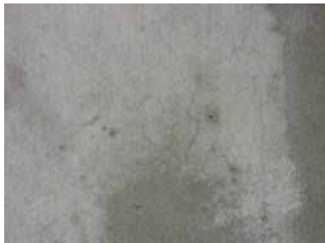
コンプロ散布後の躯体面2
