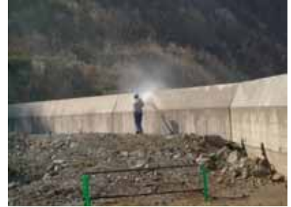
一次散水(高圧洗浄)
