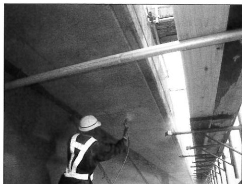
写真-3 散水養生
