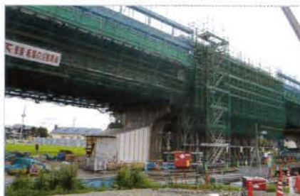
● 北陸新幹線の施工風景
