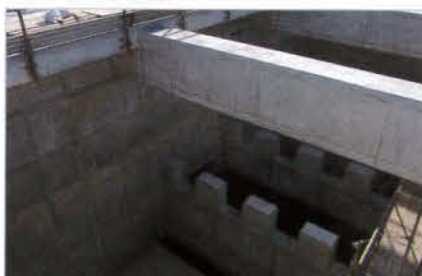
● 浄水場の施工風景
