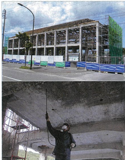
●黒松内町庁舎(北海道・築58年)での施工風景
