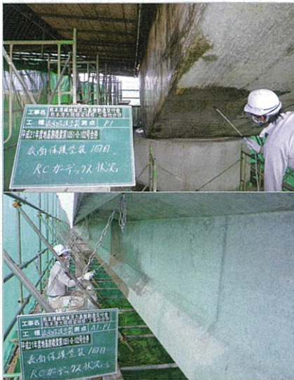
●熊本港大橋橋梁補修工事時の施工風景
