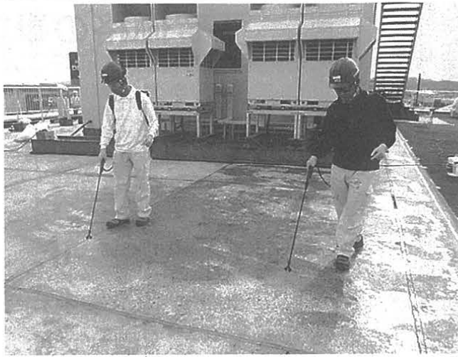
中屋敷左官工業(本社)の現場でRCカーデックスを施工している様子。
