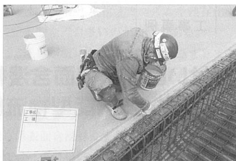
写真1 打継ぎ処理
