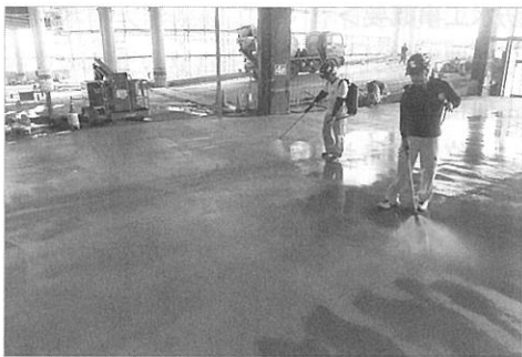
写真3 表面含浸材施工
