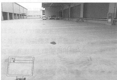
写真2 施工部位 (車路およびトラックバース)
