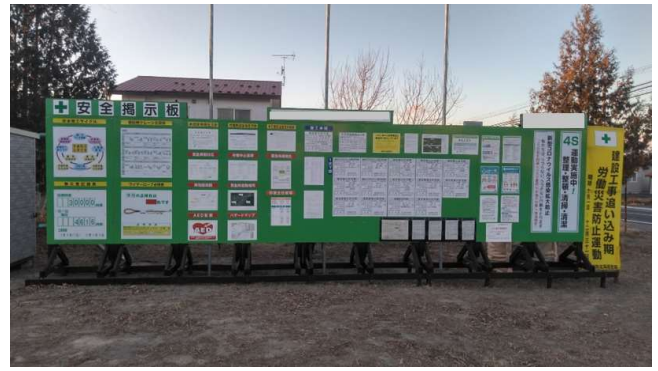
土木工事現場での適用例
