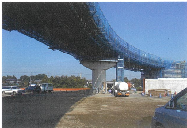
高速道路橋上部工事風景
