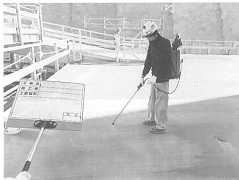
写真2 材料塗布の状況
